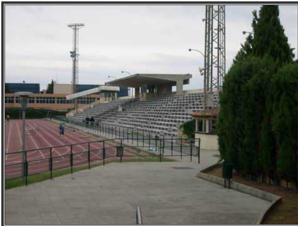
Debajo de estas graderías se almacenaron durante años parte de los muebles y objetos de decoración procedentes del derribo con nocturnidad y alevosía de la Casa del Pueblo.
