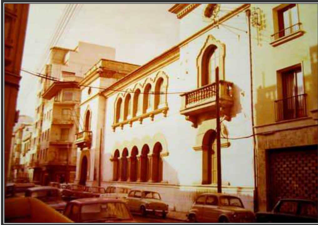
Fotografía de la fachada de la calle Reina María Cristina poco antes de su demolición. (Colección Can Verga)
